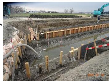
例えば1000mの護岸工事では、両岸では約5000本を利用します。現状の山で植栽が2m間隔なら、1haでは2500本植わっており、間伐率を1/2とすると1haでは1250本、集材できます。したがって1000mの護岸工事では5000本÷1250本/ha=4haの間伐が進みます。
